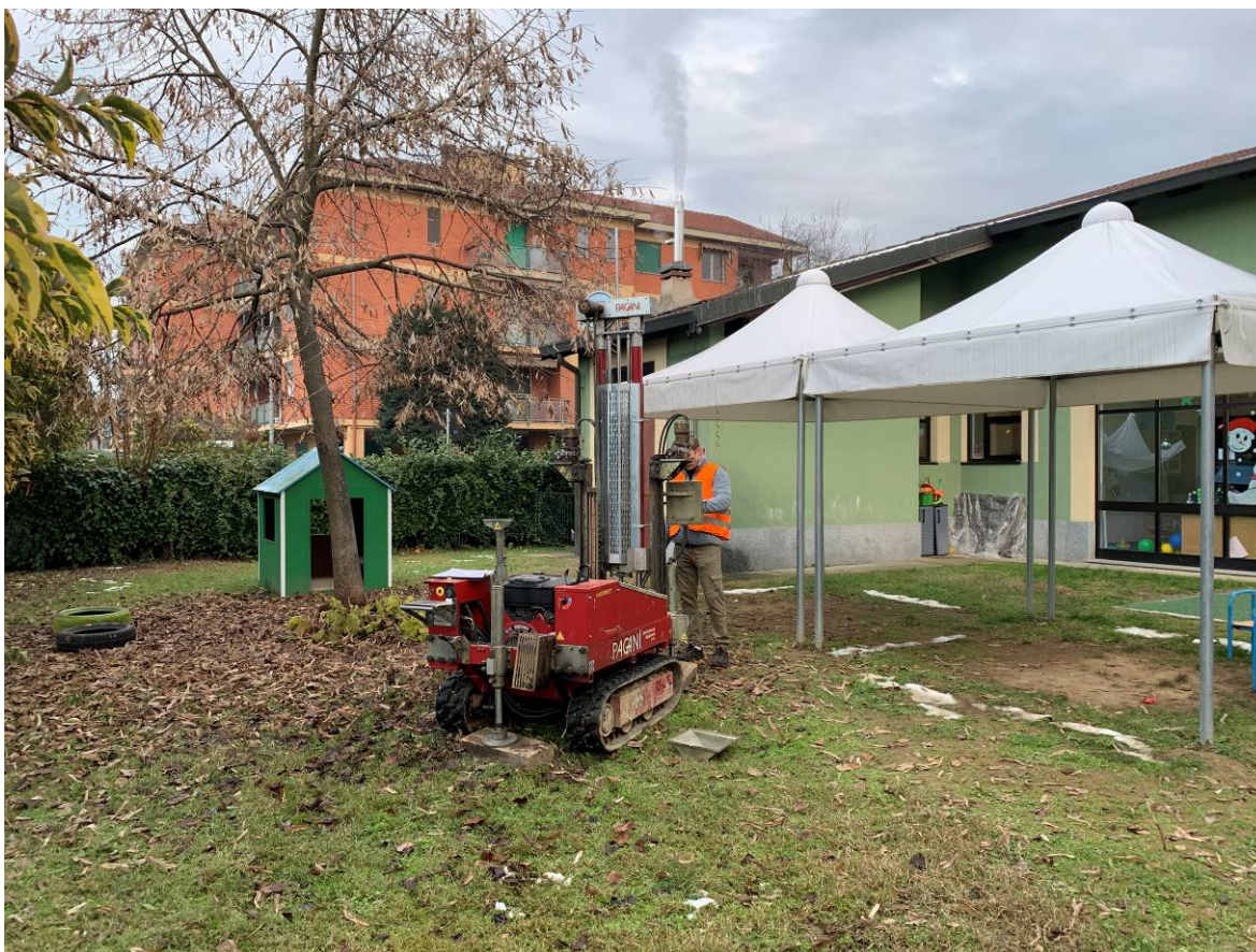
Foto 3 – L'esecuzione della prova penetrometrica DIN 3
